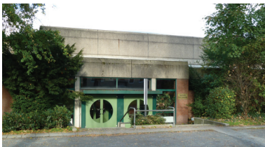
Sporthalle Kuhlo-Realschule · Ehlenruper Weg
